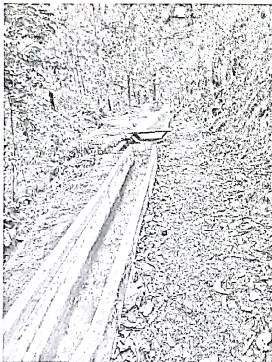
Construcción De Canal Principal Rectangular Con Concreto Reforzado En La Sierra De Las Minas
